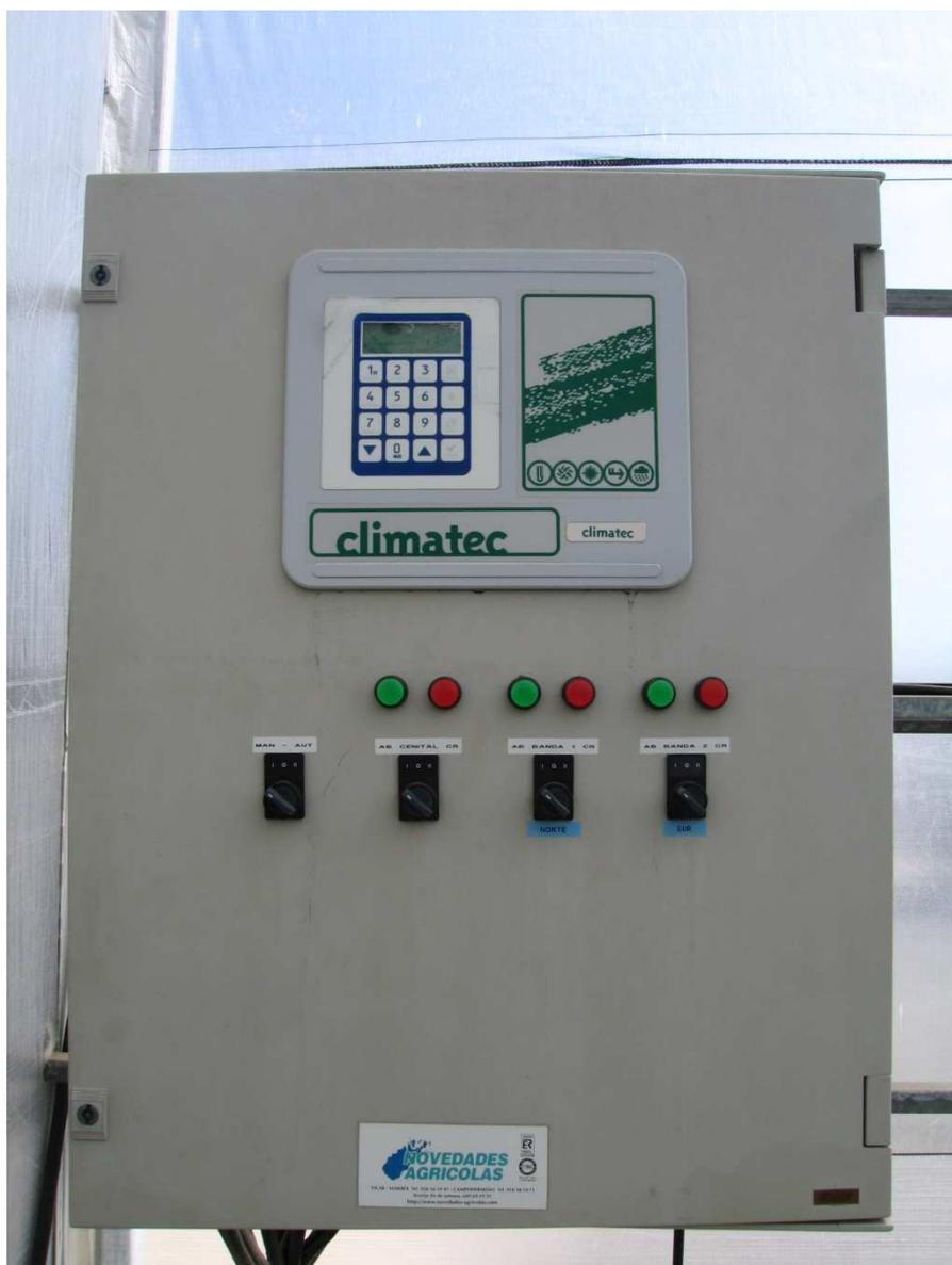
**Fotografía 22: Programador de temperatura del invernadero, que se encarga de la automatización de la apertura y cierre de la ventana cenital y las laterales.**
