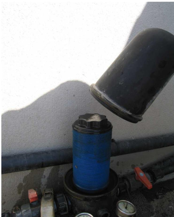
**Fotografía 17: Filtro de anillas anterior al tanque de acumulación.**
