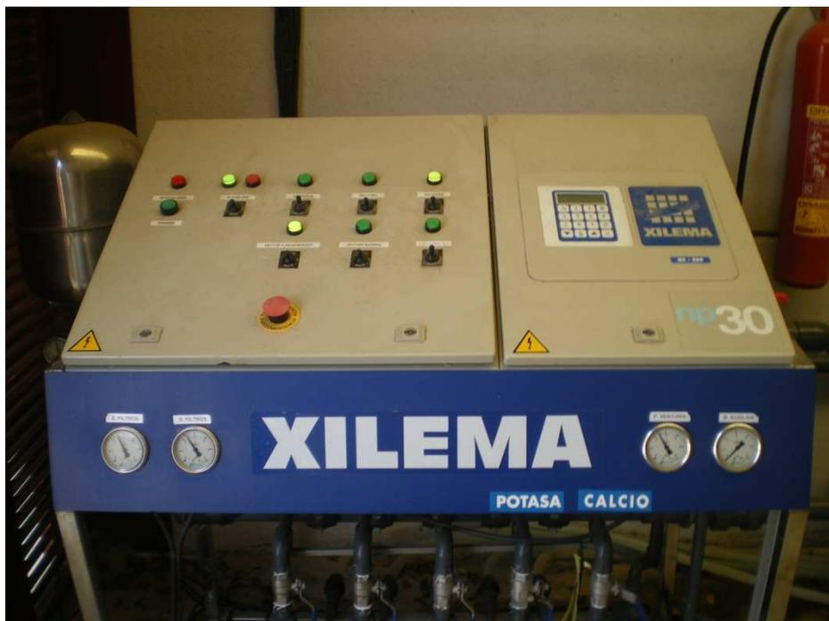
**Fotografía 23: Programador del riego.**
