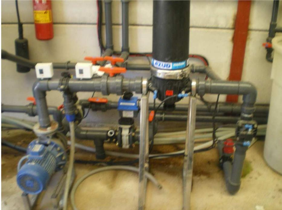
**Fotografía 18: Cabezal de riego.**
