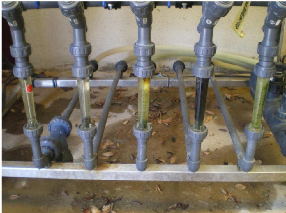
**Fotografía 19: Venturis utilizados para fertirriego.**
