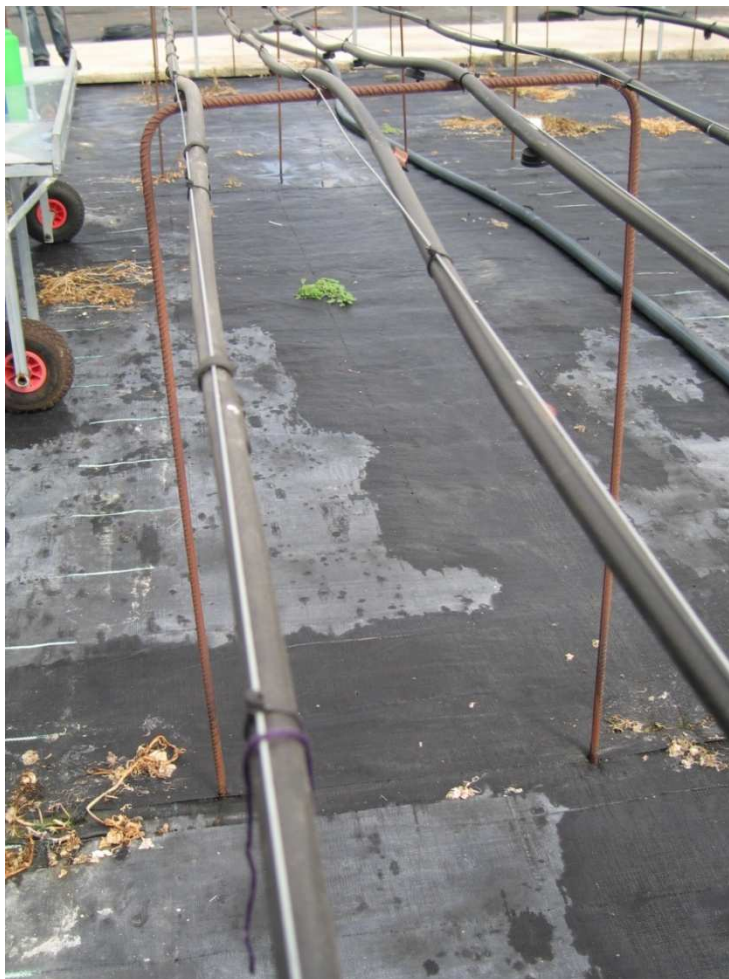
Fotografía 64: Perfiles de hierro usados como soporte de los ramales.
