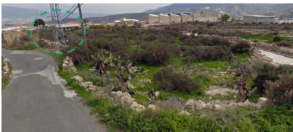
Figura 1: Torre de transformación
