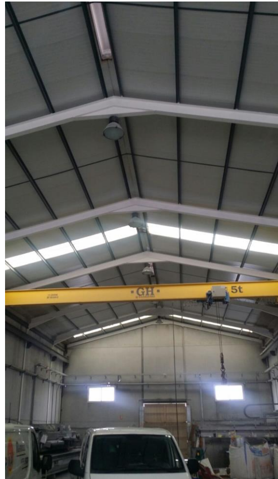
Ilustración 19. Puente grúa para mover material.
