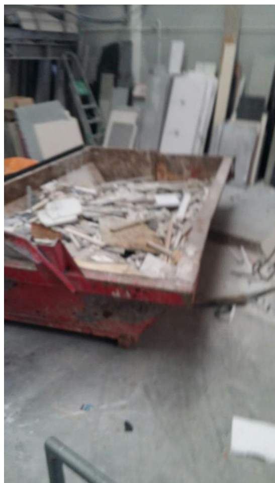
Ilustración 17. Contenedor para escombros.
