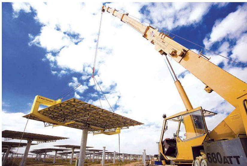
Figura 2.3 – Instalación de un heliostato [41]
