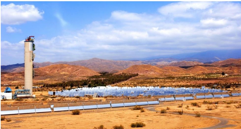
Figura 2.9 – Sistema de receptor central CESA-I de PSA, Tabernas, Almería [36]
