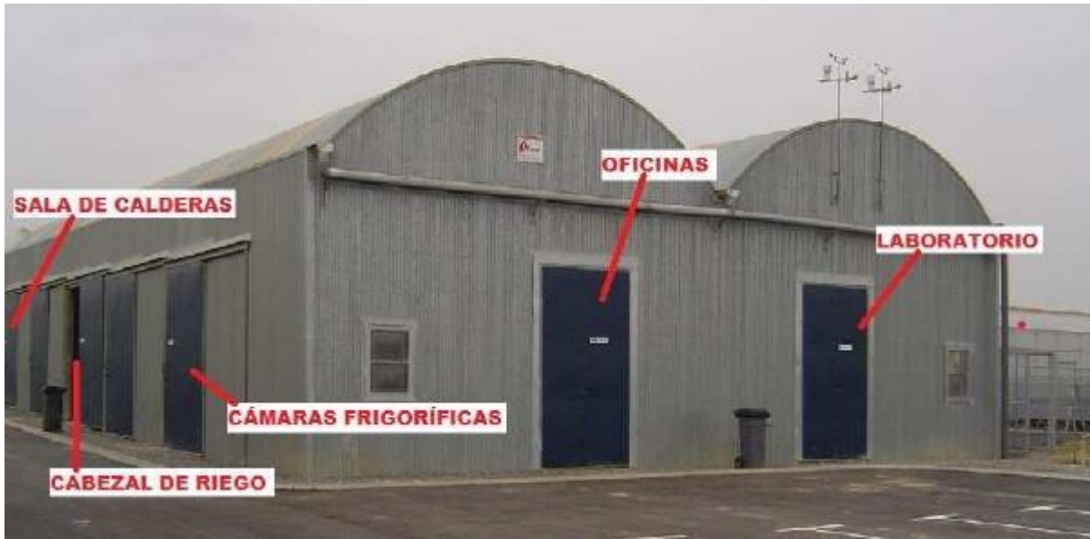
Figura 6. Detalle exterior de la nave de servicios.
