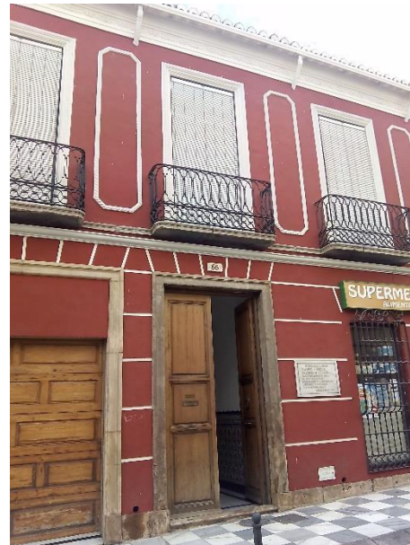
Fig. 14. Avenida Manuel Salmerón 66. Detalle paramento. Foto de la autora.
