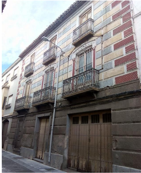
Fig. 42. C/Faura nº27, fachada principal. Fotografía de la autora.
