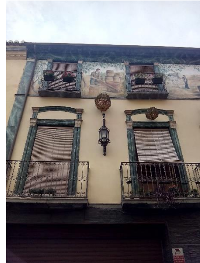
Fig. 45. C/ Faura nº40. Detalle recercado vanos. Fotografía de la autora.
