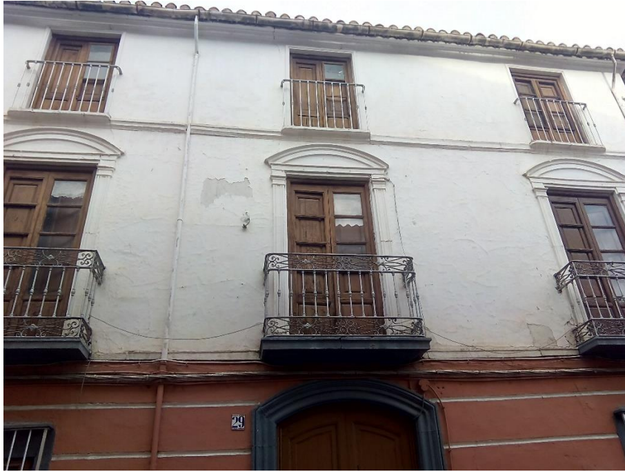
Fig. 43. C/ Faura nº29. Detalle recercado vanos. Fotografía de la autora.
