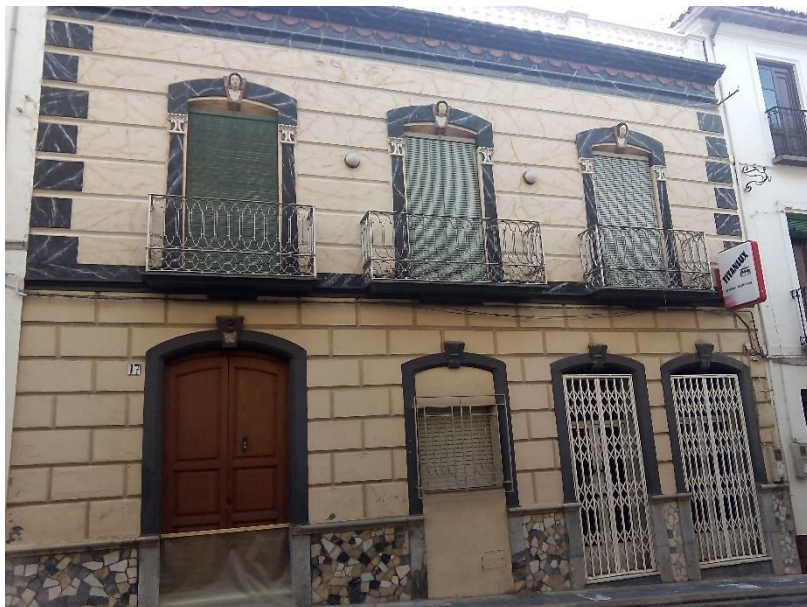
Fig. 34. C/Goya nº19, fachada principal. Fotografía de la autora.
