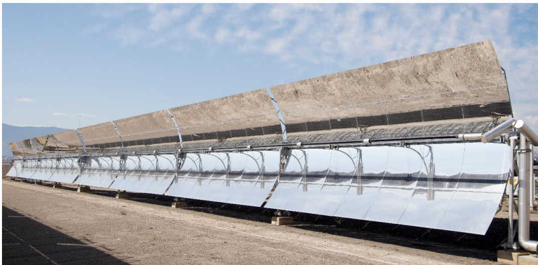
Ilustración 184. Serie de captadores cilindro-parabólicos
