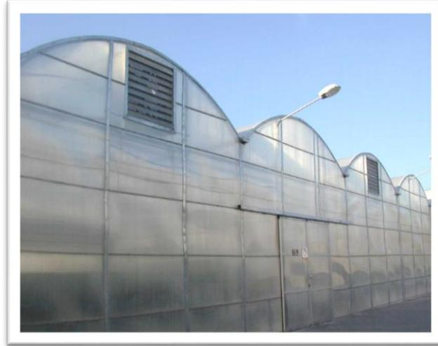
Figura 30. Fotografía de ventiladores en un invernadero multitúnel (Carmona, 2011).
