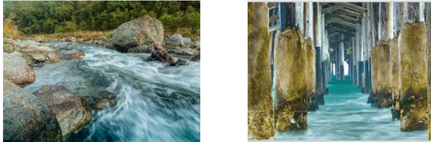
Figura 5. Presencia de biofouling en diferentes superficies en medios acuosos.
