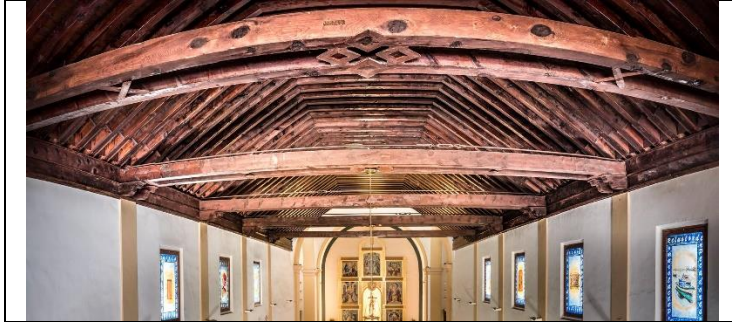
Figura 33: Armadura mudéjar en la Iglesia de la Virgen del Rosario (1757) (Fuente: Blas Fuentes Mañas)
