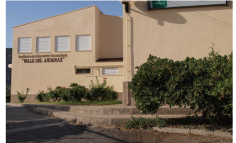
Fachada del Instituto Valle del Andarax, de Canjáyar.
