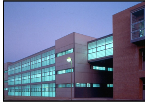
Ilustración 6. Fernando Carrascal Calle y José María Fernández de la Puente. Edificio Científico Técnico, UAL (2011). Fuente:
