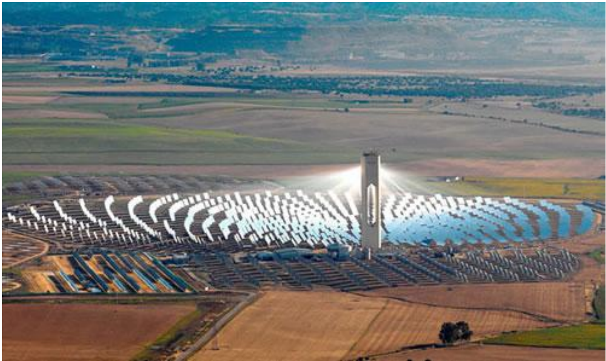
Figura 1.5: Campo de helióstatos y torre.
