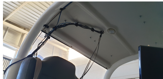
(d) Cableado interior de los paneles superiores
