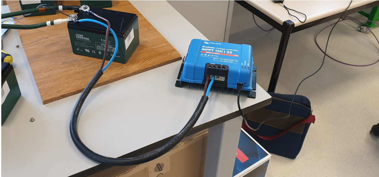
Figura 5.3: Banco de ensayos para realizar la lectura del regulador de carga
