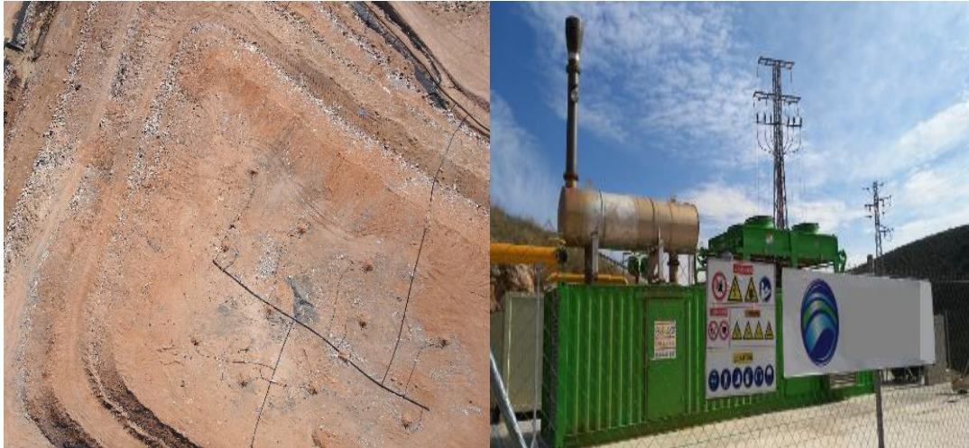
Figura 9. Campo de gas y generación de energía en planta de RSU 1
