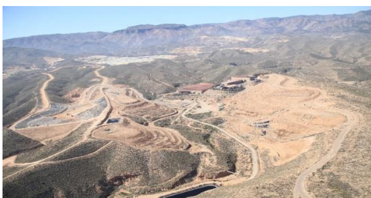
Figura 6. Planta de tratamiento y vertedero controlado de Gádor
