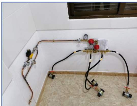
Imagen 2.2. Instalación de gas.
