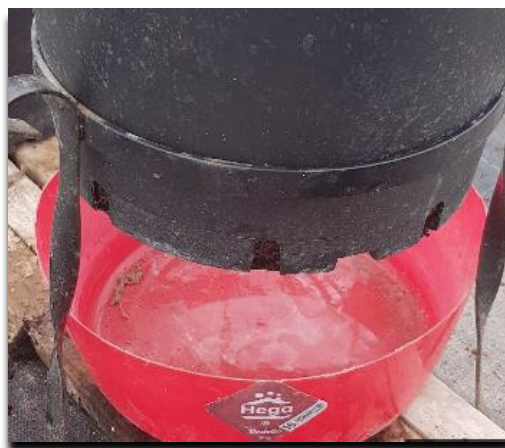
Fotografía 4.4: Detalle bandeja de drenaje colocada.
