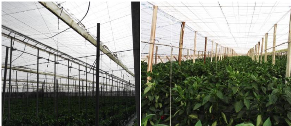
Figura 3: A la izquierda invernadero de “raspa y amagado” y a la derecha “parral plano”.
