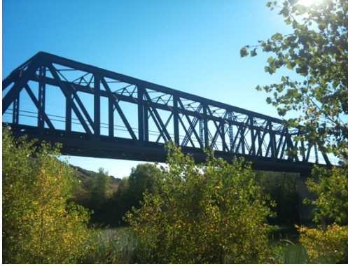
Figura 5.19. Puente real formado por una estructura celosía tipo Pratt
