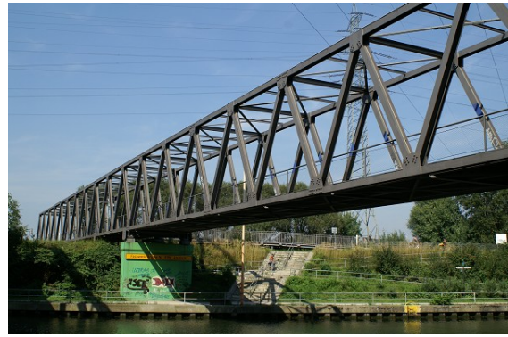
Figura 5.20. Puente real formado por una estructura reticular
