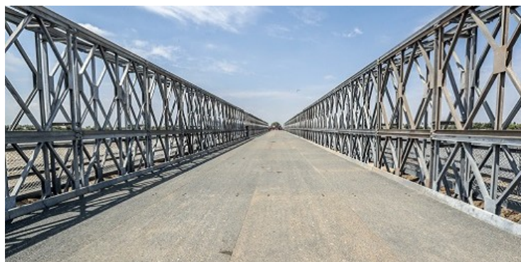
Figura 5.18. Puente real formado por una estructura en celosía.
