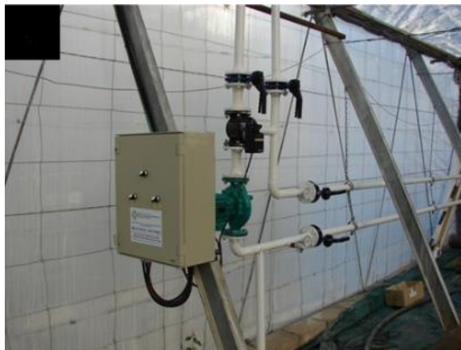
Figura 2.24 Válvula mezcladora de 3 vías [13]
